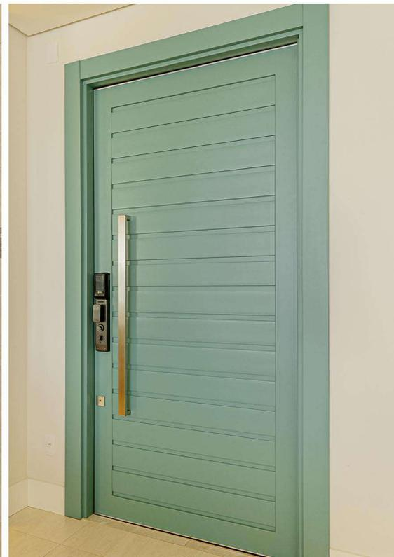
Portas com montantes em PVC Wood e chapas de PVC expandido
